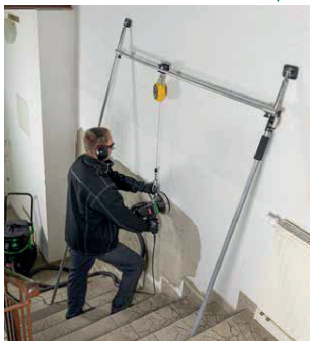
Rimozione dell'intonaco durante i lavori di ristrutturazione
